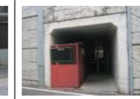
47 ごみステーション。死角になっていて危険。
