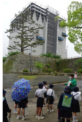
改装工事中の福山城
