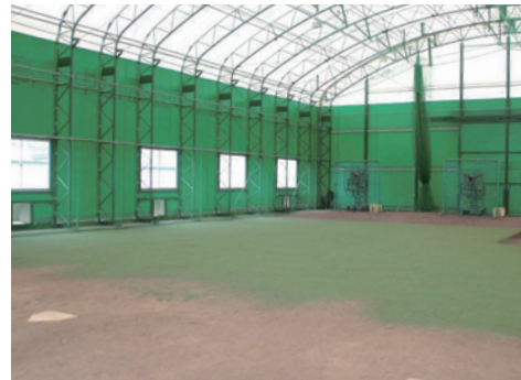
屋内練習場(内部)
