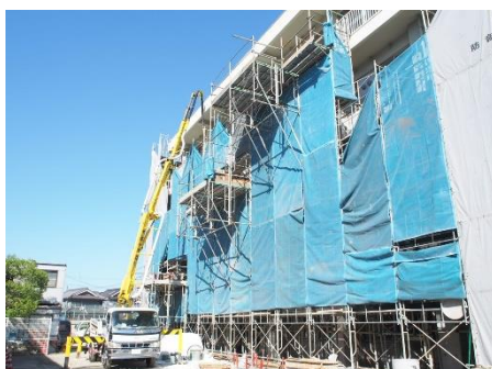
耐震補強中の様子
