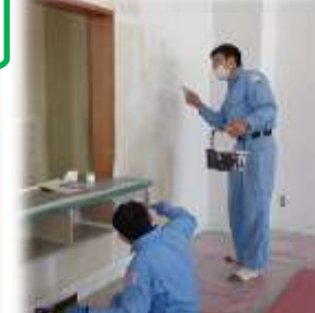
技術員さんが図書館内の壁を白く塗ってくれています。
