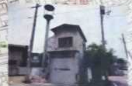
霞消防団 消防機庫
