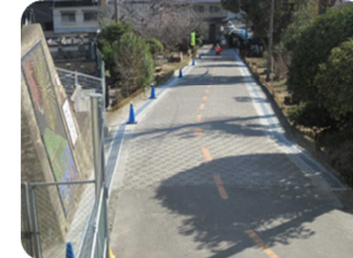
おはよう坂側溝拡張工事修了!
