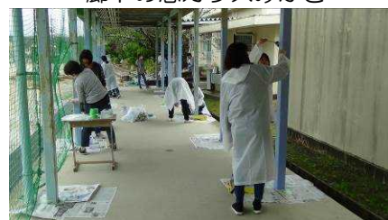
渡り廊下鉄柱のペンキ塗り
